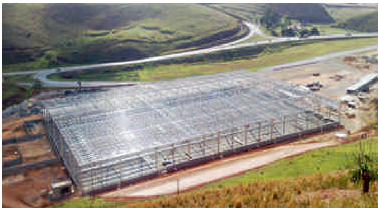
Anexo 8 (Vista Aérea do novo Centro de distribuição, dia 27/10/2010)
