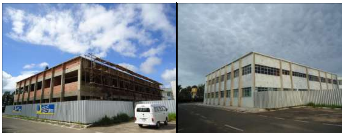
Figura 3.11: Construção do Bloco F.
