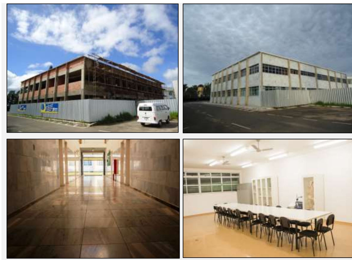
Figura 3.14: Construção do Bloco F.
